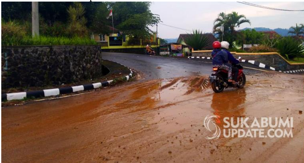
Gambar 1.2 Kondisi banjir lumpur di Jalan Lio Santa RT 01/05 Kelurahan Gedongpanjang, Kecamatan Citamiang, Kota Sukabumi
