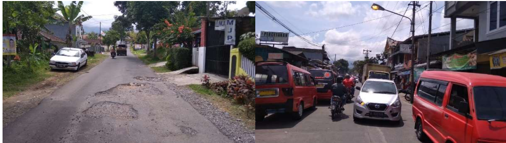
(a) Kondisi Kerusakan Jalan (b) Kondisi Volume Kendaraan
